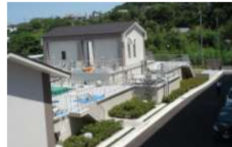
星の里浄水場
