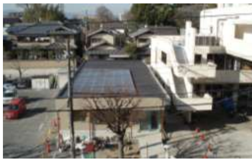
屋根に設置された太陽光パネル (市役所別館の増築庁舎)
