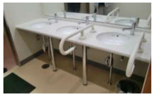
第1中学のトイレ洗面所
