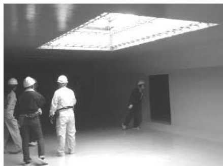
松塚公園地下の污水貯留槽
