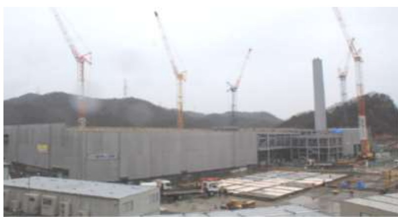
新ごみ処理施設工事の状況（平成29年3月時点）
