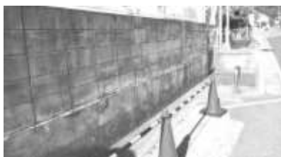
撤去中のブロック塀（星田小）
